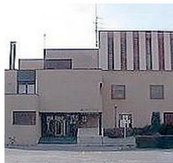
BILANCIO Nella foto la palazzina dove ha sede il municipio di Tresigallo
